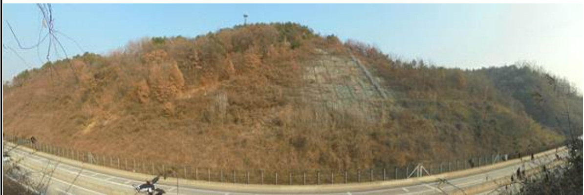
천안절토 18 (순천기점 230.430k~230.650k / STA. 5공구 0k100~4공구 11k950)
