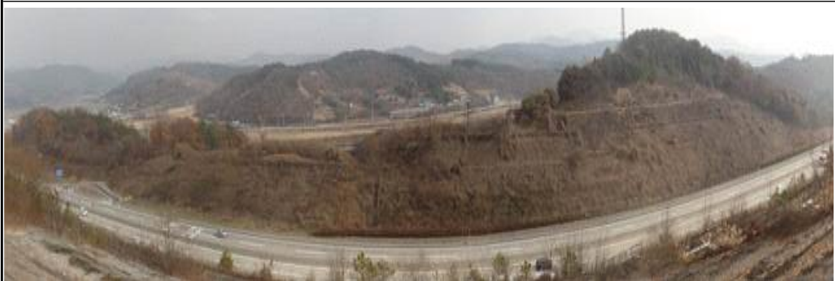
천안절토 22 (순천기점 222.470k~223.070k / STA. 5공구 7k470~8k070)
