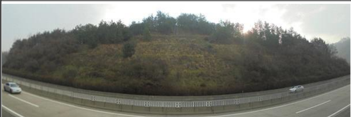
천안절토 20 (순천기점 227.491k~227.713k / STA. 5공구 2k793~3k015)
