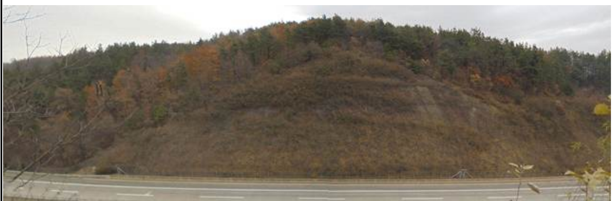
천안절토 15 (순천기점 235.120k~235.310k / STA. 4공구 7k281~7k480)
